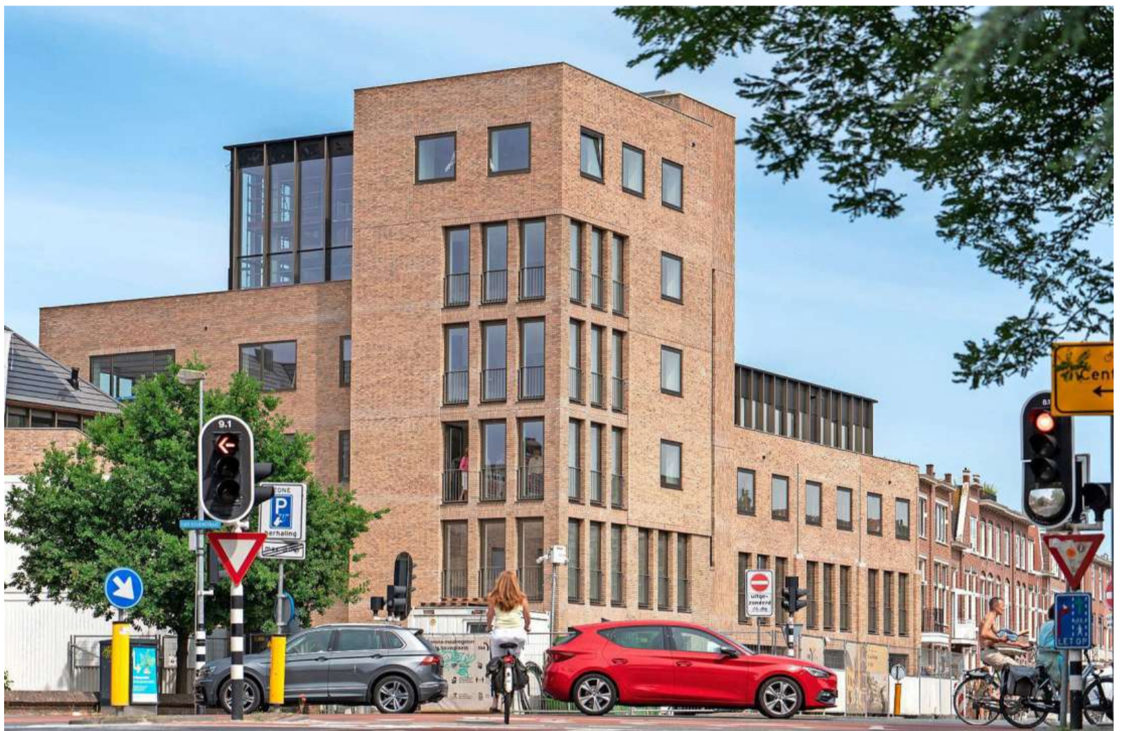
De nieuwbouw van De Vierhoek aan de Tempeliersstraat nadert zijn voltooiing.
